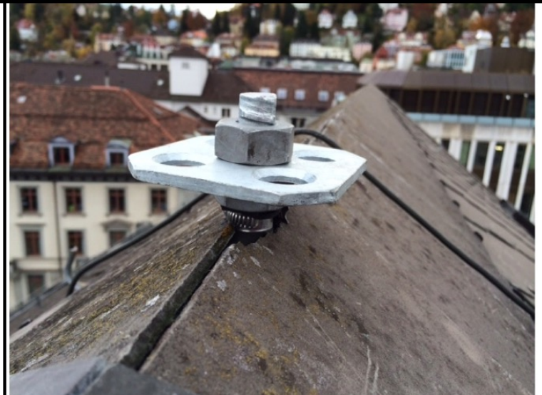
steifer Anschlagpunkt auf Firstlinie
