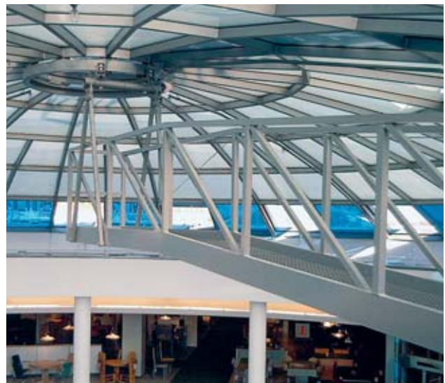
14 Fahrbare Brücke in rundem Gebäude. Von dieser Einrichtung aus können Deckeninnengläser gereinigt und allgemeine Instandhaltungsarbeiten ausgeführt werden.
