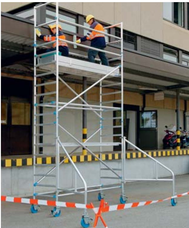
23 Fassadenreinigung von einem Rollgerüst aus.
